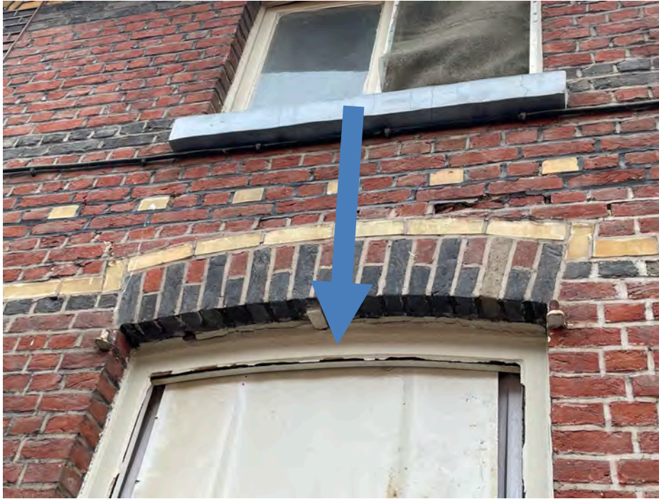
Figuur 4: Voorgevel ramen
