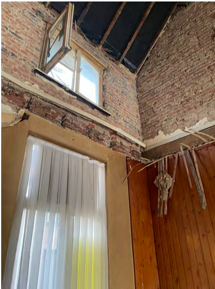
Figuur 1: Binnenkant gevel rechts
